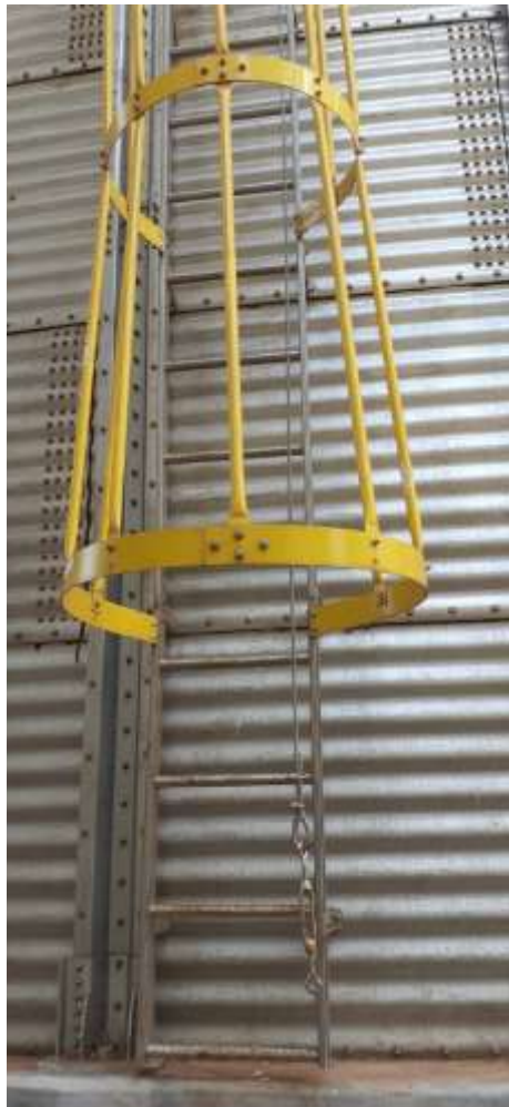
Figura 05 – Acesso a parte superior do Silo
