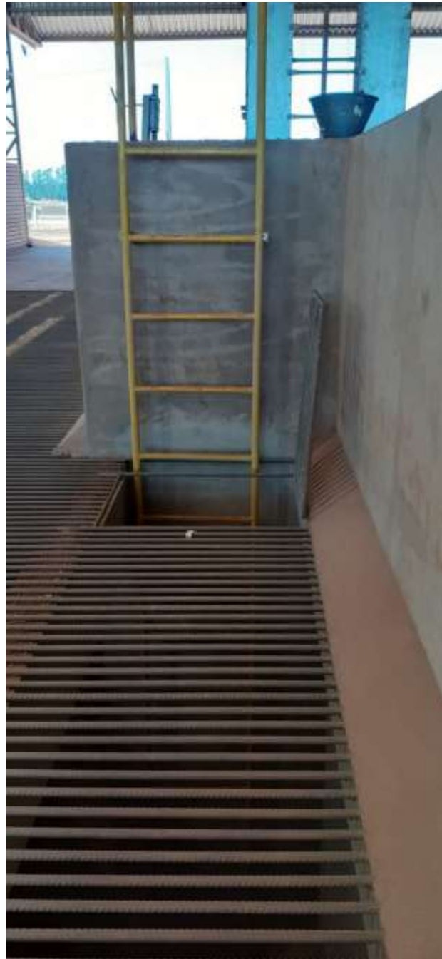
Figura 06 – Acesso à Moega Fonte: Próprio Autor (2019)
